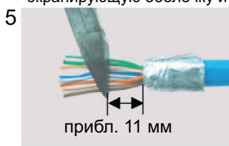
5 Раскрутите и выпрямите жилы по порядку и подрежьте их, оставив 11 мм.
