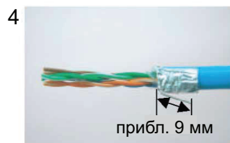
4 Отогните провод заземления и обрежьте его, оставив 9 мм.
